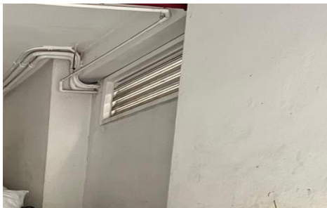
ระบบระบายอากาศภายในห้องพัสดุฝอย
