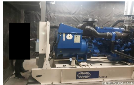
ทดสอบเครื่องยนต์กำเนิดไฟฟ้าสำรองประจำสัปดาห์
