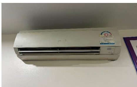
ระบบปรับอากาศแบบแยกส่วน
